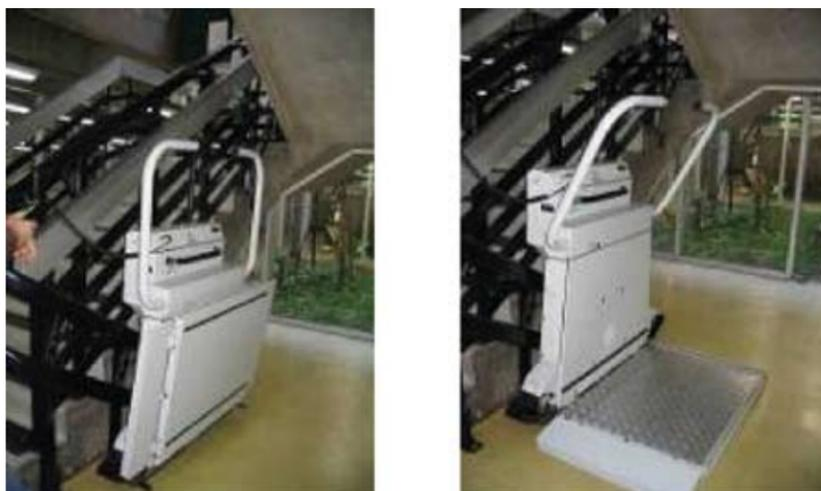
Fotos 06 e 07 - Plataforma basculante tipo inclinado
